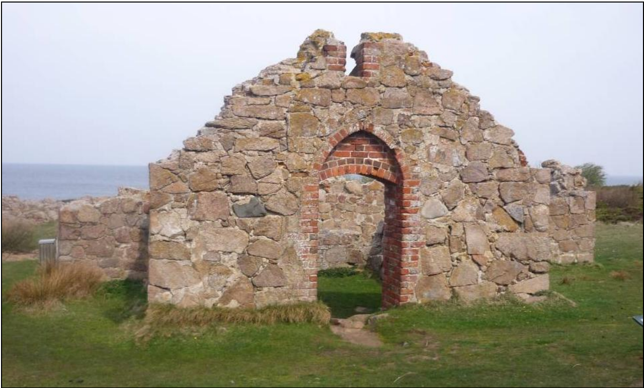
Indgangen til kapellets våbenhus set fra syd. Det bemærkes, at døråbningen er spidsbuet på ydersiden og bredbuet på indersiden. Mens døren, utvivlsomt ligesom de længst forsvundne vinduer, er muret op i brændte teglsten ("munkesten"), så er murene i øvrigt opført i groft tilhugne kampesten, hvorimellem sprækker er fyldt ud med brokker af teglsten. Foto af Sascha Helsengren Hansen 2009.
